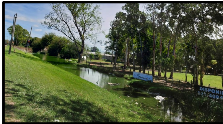
Figura 52 – Canal de drenaje pluvial
