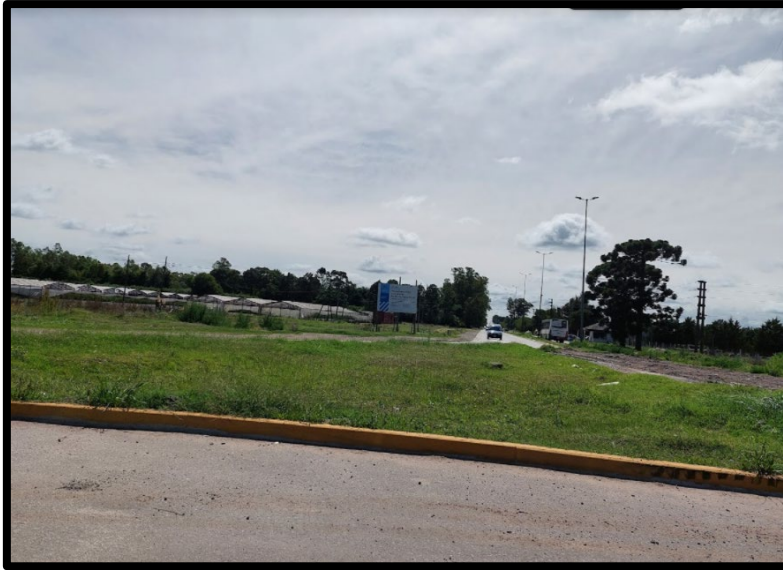
Figura 54 – Finalización del tramo del Proyecto
